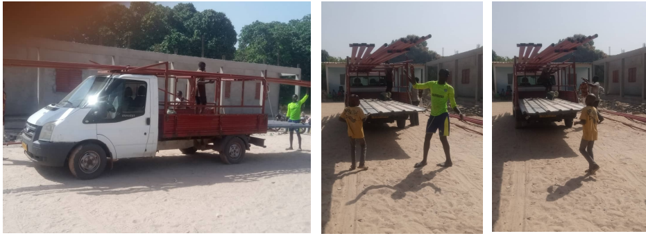
Het materiaal voor de dakconstructie werd op 14 februari 2021 op het terrein afgeleverd.
