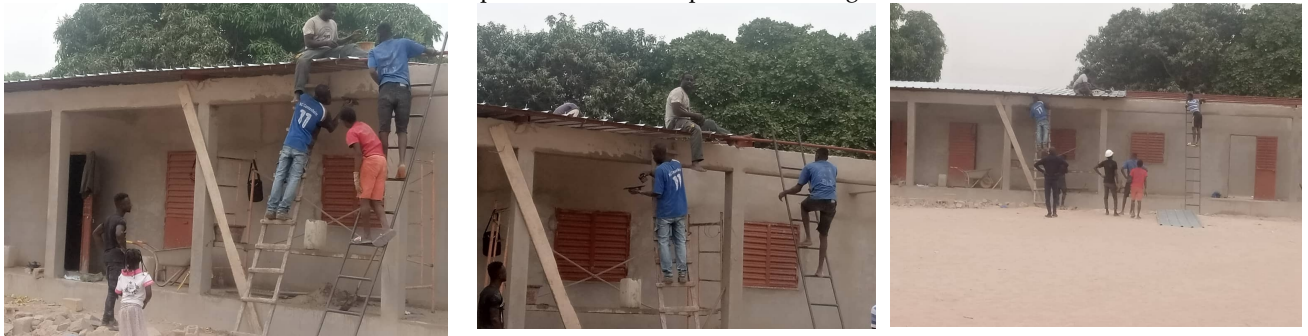
Op 17 februari was de constructie van het dak tot de helft van het gebouw gevorderd.
