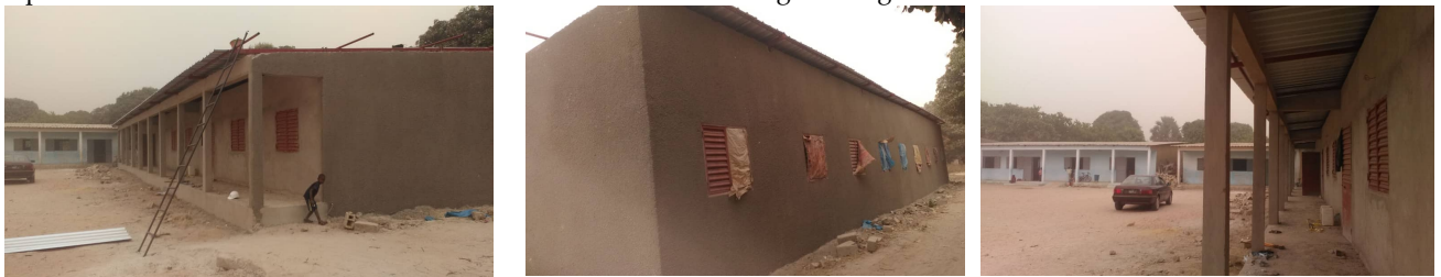
Op 18 februari was de dakconstructie klaar. Op de foto's is ook te zien dat het gebouw aan de achterkant en de zijkanten met een afwerkende cementlaag is bespoten. De voorkant wordt later, tegelijk met het binnenschilderwerk, met gekleurde cement bespoten
