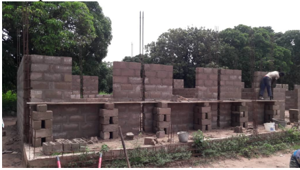
Op 1 oktober was de onderste bouwlaag gevoegd en werden de muren verder opgetrokken.
