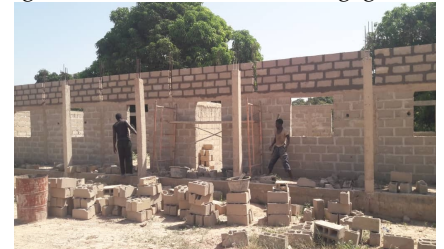
10 november was de bouw gevorderd tot de dakrand. De betonnen palen, die de muren verankeren waren gegoten.
