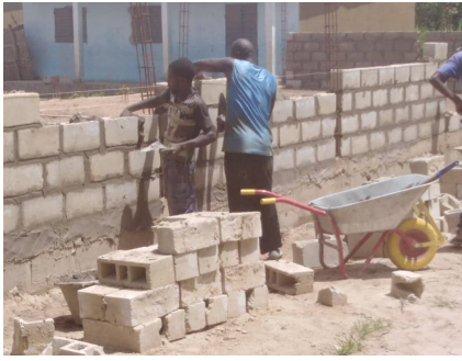
27 september waren de muren 1,5 m hoog. De betonnen palen voor de verankering van de muren worden later gegoten.
