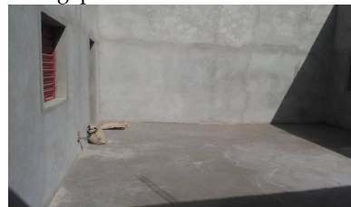
Begin februari werd de vloer afgesmeerd en werd de buitenkant met een laag cement bespoten.
