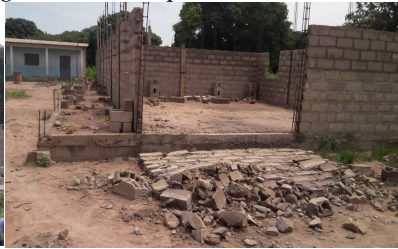
2 oktober blies een zware storm een muur om. Gelukkig kon een deel van de stenen opnieuw worden gebruikt.
