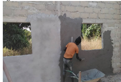
In december werden de muren aan de binnen- en buitenkant met cement afgesmeerd
