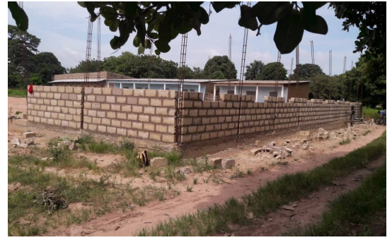
27 september waren de muren 1,5 m hoog. De betonnen palen voor de verankering van de muren worden later gegoten.
