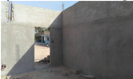
In december werden de muren aan de binnen- en buitenkant met cement afgesmeerd
