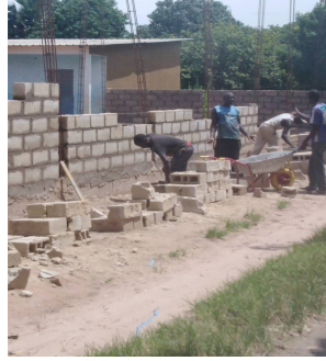
27 september waren de muren 1,5 m hoog. De betonnen palen voor de verankering van de muren worden later gegoten.
