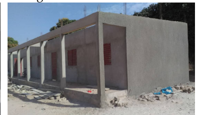
Begin februari werd de vloer afgesmeerd en werd de buitenkant met een laag cement bespoten.
